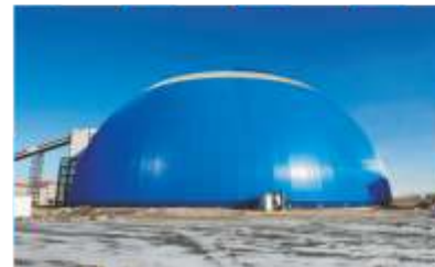
HUOLINHE COAL STORAGE DOME
