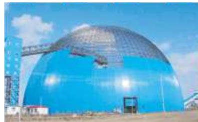
HUOLINHE COAL STORAGE DOME
