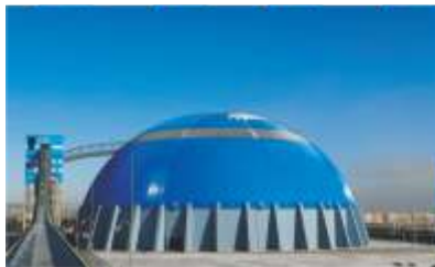
HUOLINHE COAL STORAGE DOME
